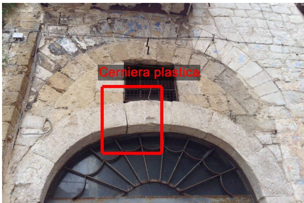
Fig. 2 – Esempio di cerniera plastica in un arco a tutto sesto di pietre conce
