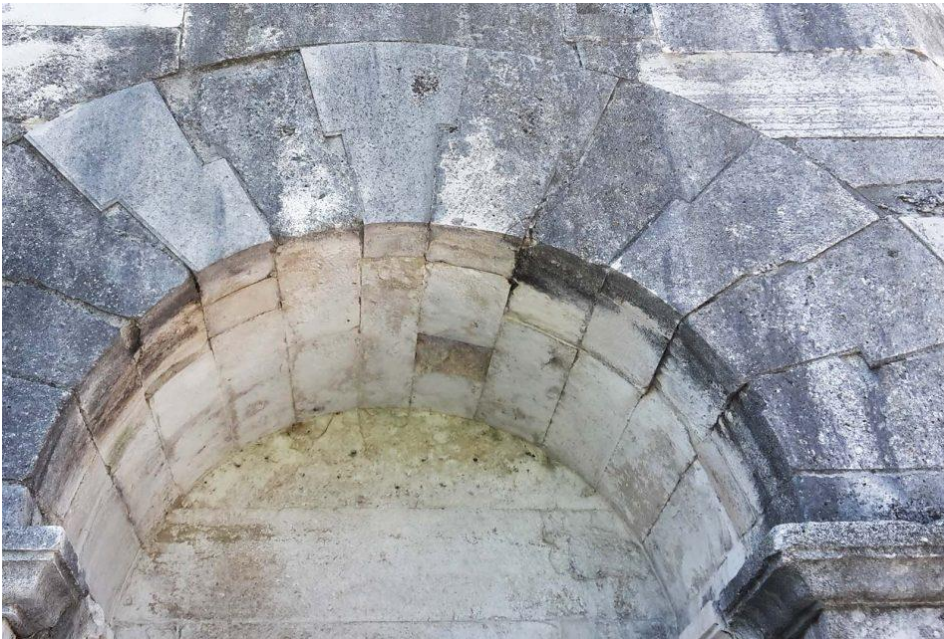
Fig. 11 – Ravenna, Mausoleo di Teodorico (VI secolo): particolare di un arco a tutto sesto di pietre conce con giunti a dardo di Giove
