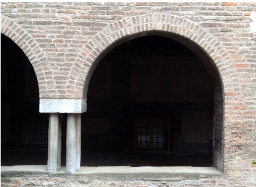
Fig. 12 – Bologna, chiostro della Basilica di Santo Stefano (XII secolo): esempio di archi con ghiera doppia di mattoni
