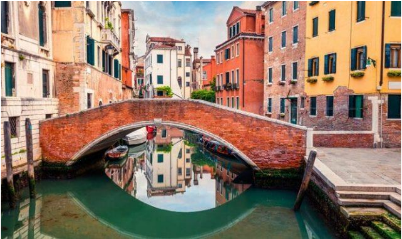
Foto 4 – Nel centro storico di Venezia i ponticelli superabili solo grazie a scalinate costituiscono un ostacolo insormontabile per persone con disabilità e sedia a rotelle
